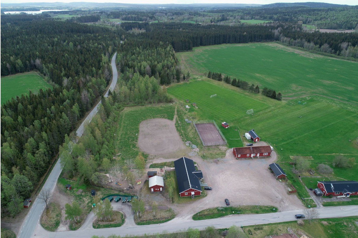
Flygbild över planområdet. Förskolan och återvinningsstationen närmast i bild. Resten utgörs av idrottsplats.
