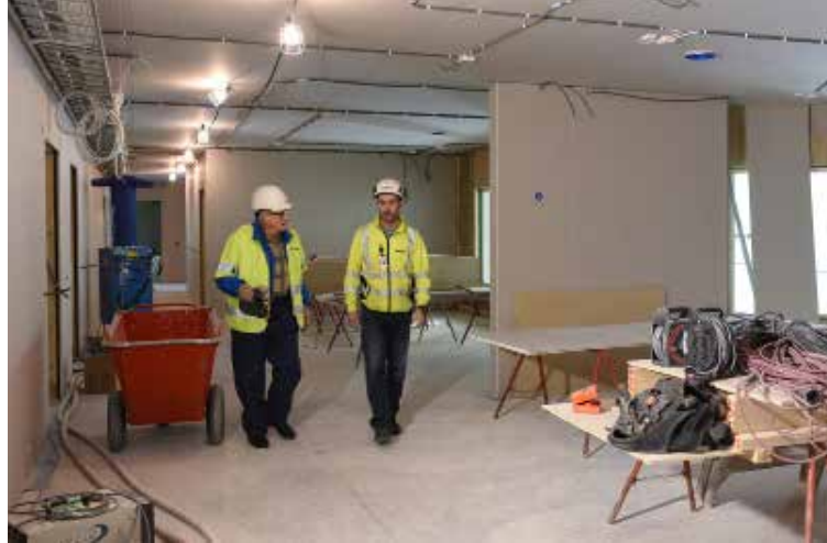
Haldo Hagström guidas av Per Johansson från byggföretaget Novab.
