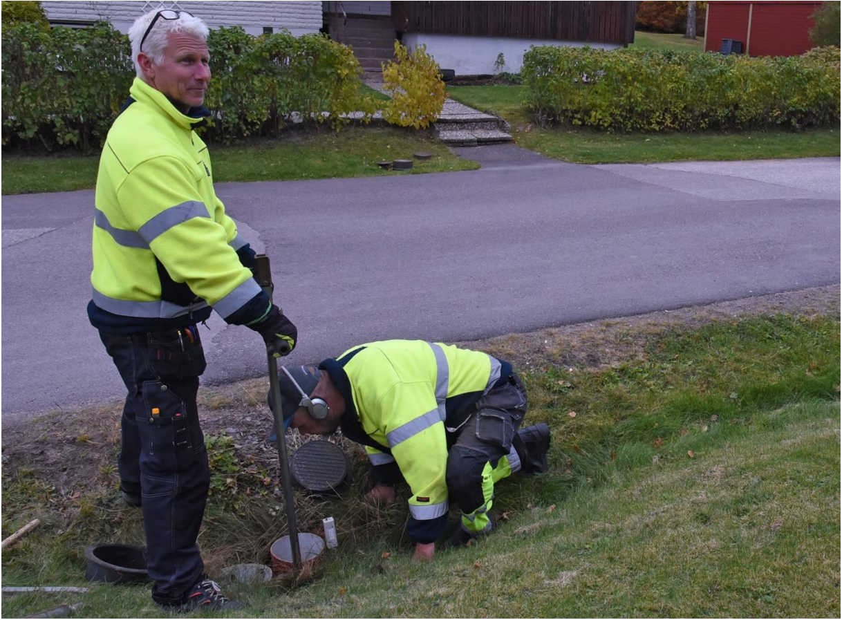
På jakt efter vattenläckor – med ljudförstärkare.
