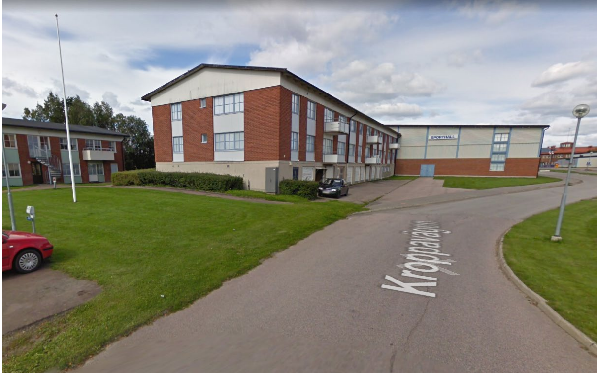
Befintlig sporthall sett från öster.
