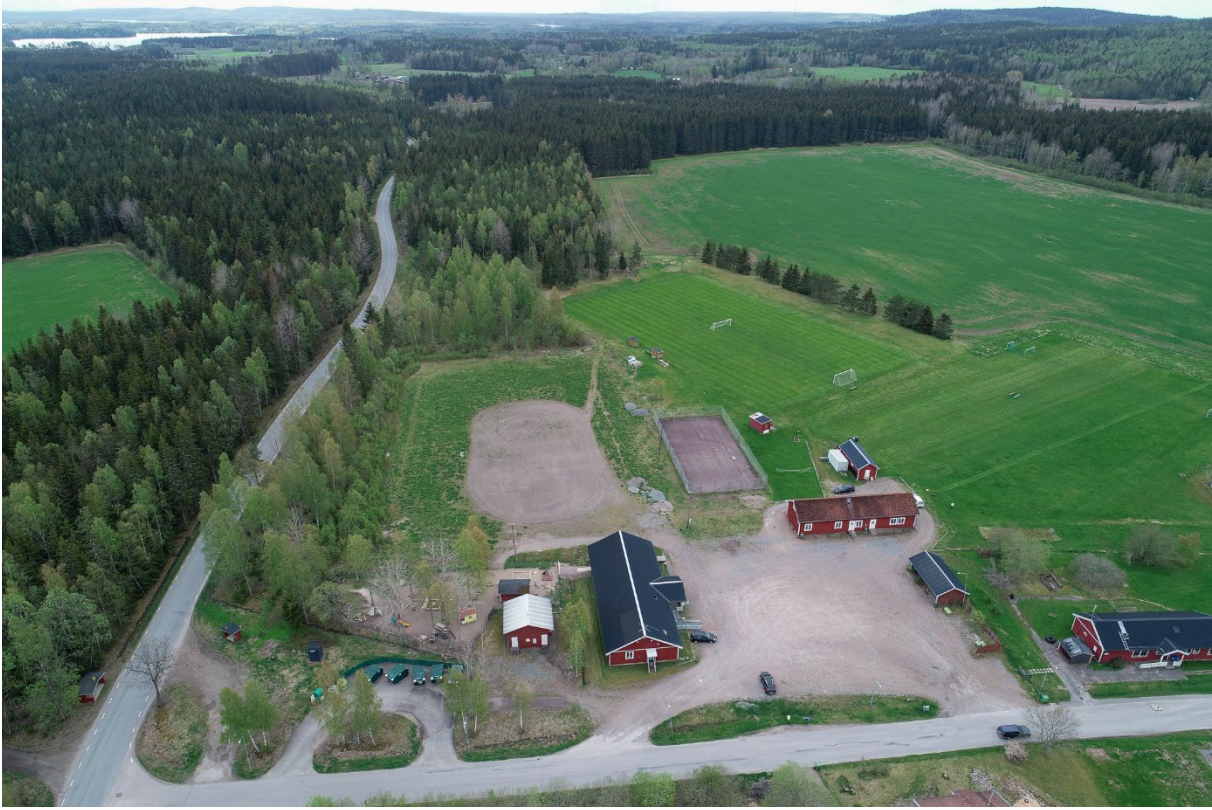
Flygbild över planområdet. Förskolan och återvinningsstationen närmast i bild. Resten utgörs av idrottsplats.
